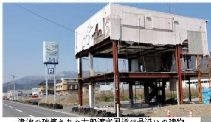
津波で破壊された大船渡市国道45号沿いの建物
