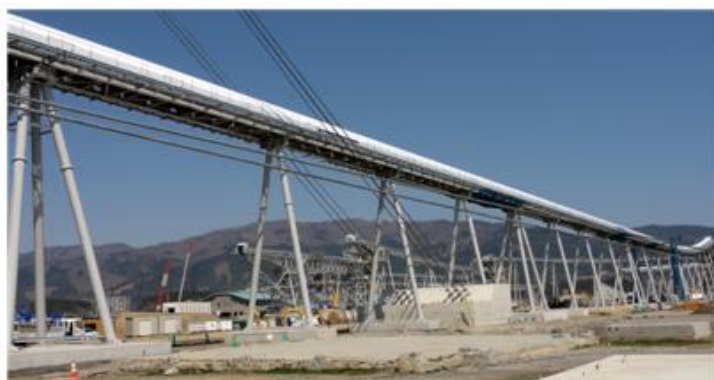
一面荒野と化した元市街地を覆う巨大土砂搬送システム
