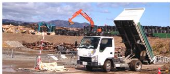
放射性物質を含む瓦礫の一時保管場所
