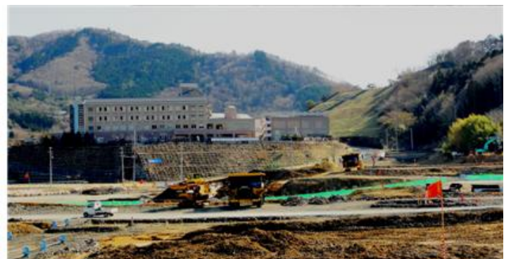
土地の嵩上げが進む女川中心部と2階まで津波が押し寄せた町立病院
