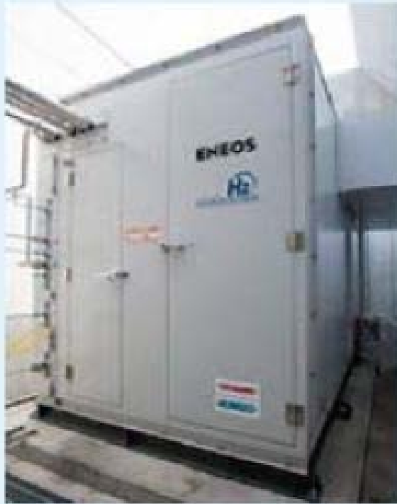
HySUT・海老名中央水素ステーションに納入したFCV充填用水素圧縮機ユニット 写真提供：JX日鉱日石エネルギー殿
