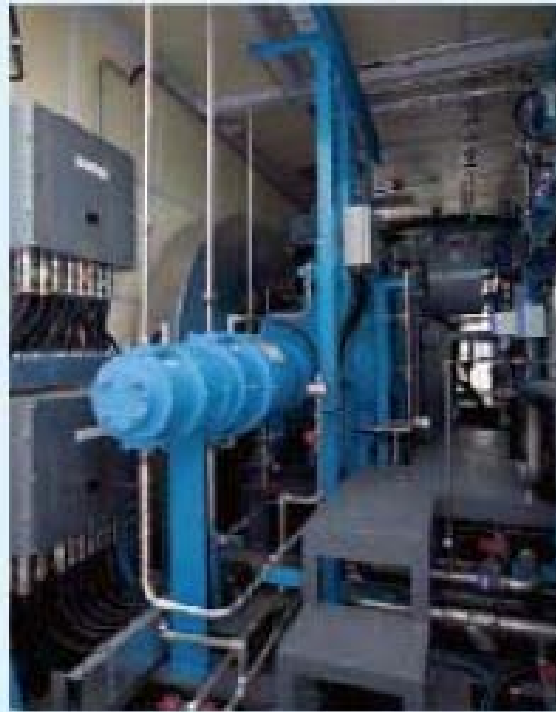
HySUT・海老名中央水素ステーションに納入したFCV充填用水素圧縮機ユニット 写真提供：JX日鉱日石エネルギー殿
