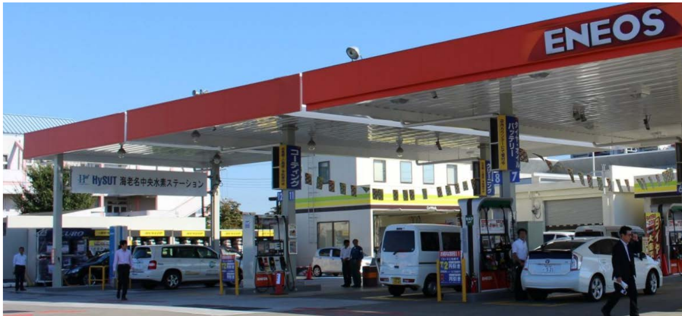
神奈川県海老名市 日本初ガソリンスタンド 併設ステーション
